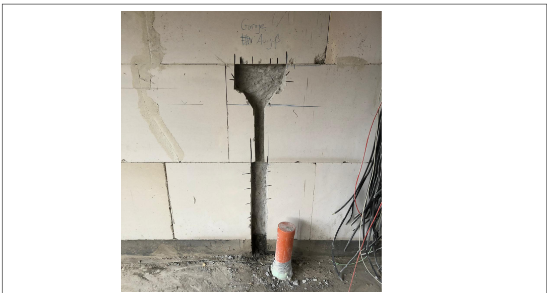
Abb. 7: Wandschlitze (Quelle: eigene Darstellung)
