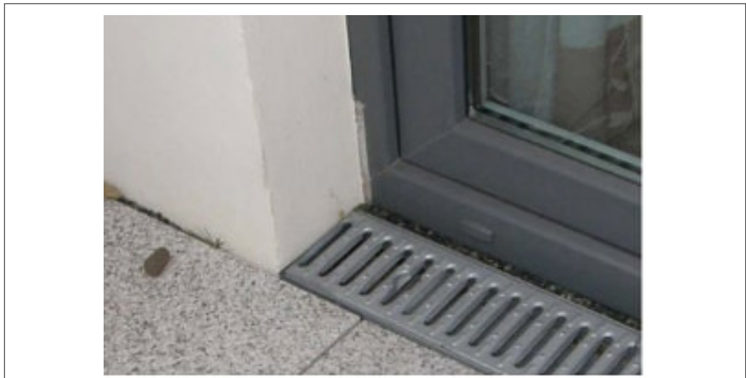
Abb. 12: Anschluss bodentiefes Element (Quelle: Wetzel 2013, S. 28)
