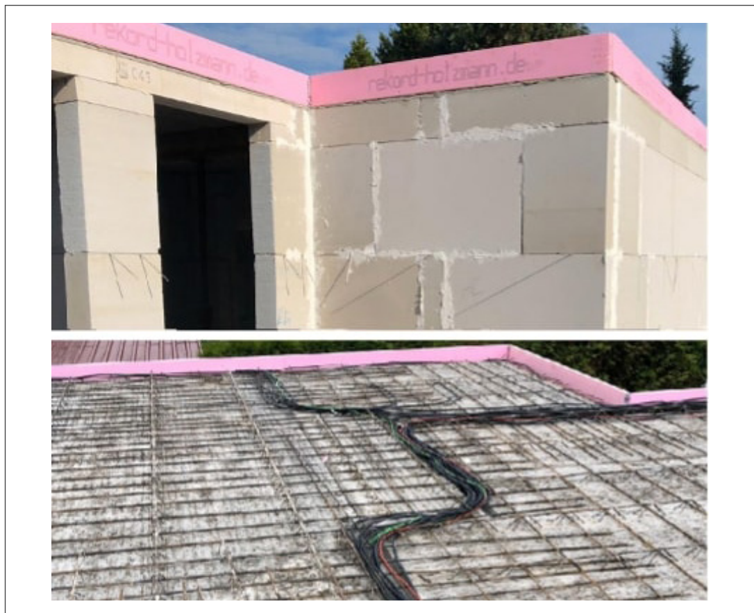
Abb. 9: Randdämmstreifen (Quelle: eigene Darstellung)
