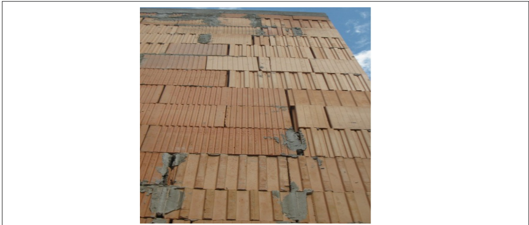
Abb. 6: Nichteinhaltung des Verbandes (Quelle: anonymisierter Sachverständiger)
