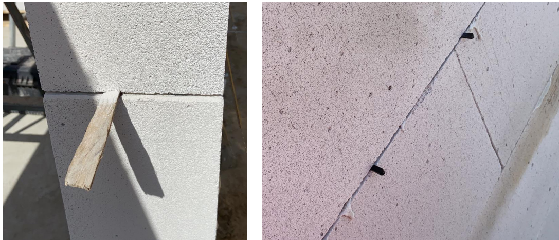
Abb. 4: Keile in der Lagerfuge (Quelle: eigene Darstellung)
