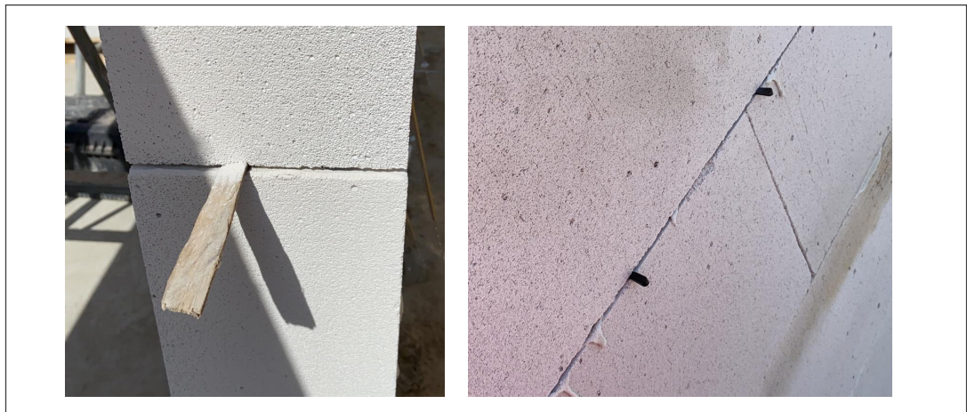
Abb. 4: Keile in der Lagerfuge (Quelle: eigene Darstellung)
