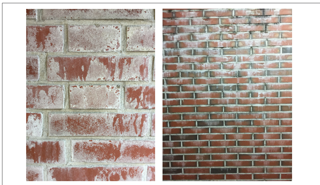
Abb. 11: Ausblühungen (Quelle: eigene Darstellung)
