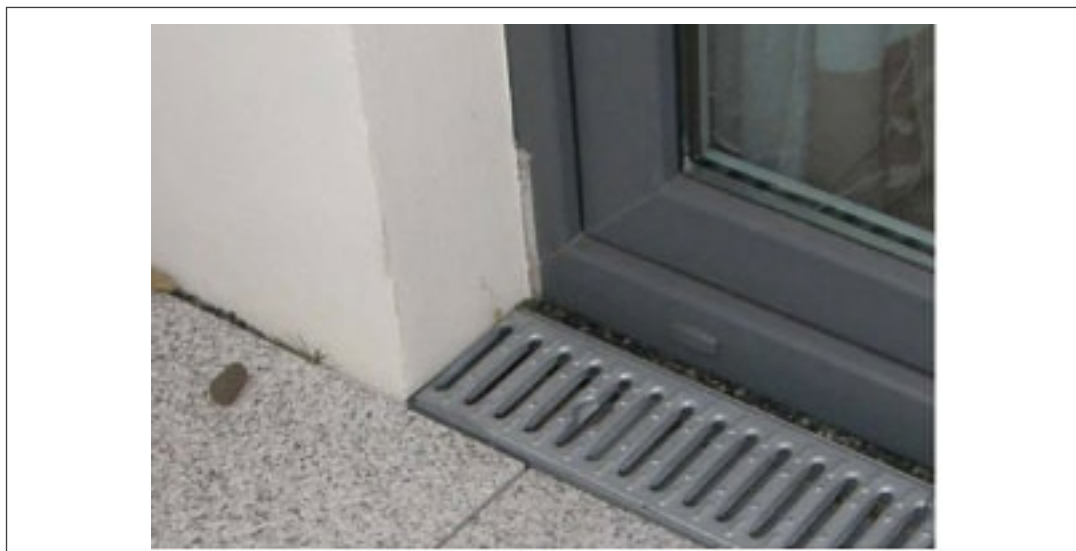
Abb. 12: Anschluss bodentiefes Element (Quelle: Wetzel 2013, S. 28)
